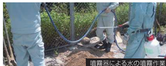
噴霧器による水の噴霧作業
