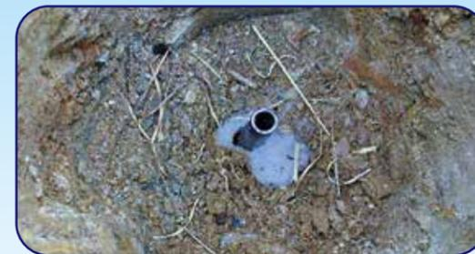
スラストパイプの上部が少し見える程度で打ち込みを終えてください。1本目のスラストパイプ打ち込みは終了です。
