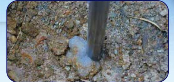
スラストパイプを地面に自立させた後、上端より低減材を注入し、スラストパイプの側面から低減材が出てくることを確認します。
