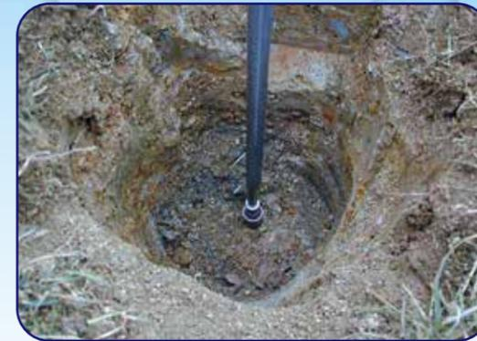
750mm以上の規定深度にφ500mm程度の掘削穴を掘り、ブレイクアローとスラストパイプを繋いで、掘削穴の中心部に差し込みます。
