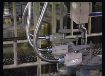
●リミットスイッチ交換工事
