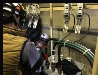
●トランス組立、ヒューズ交換工事
