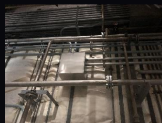
●電気設備据付工事
